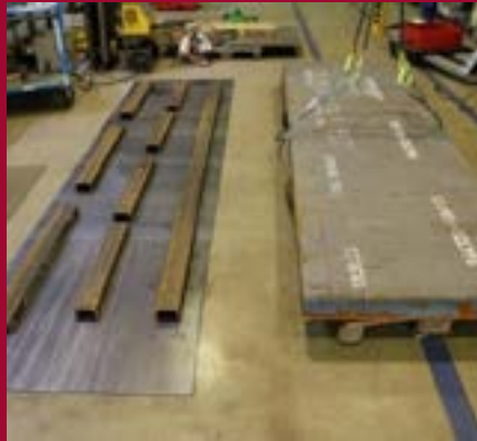
2. Đặt tấm đỡ lên trên (trong trường hợp này là dầm chữ U)
