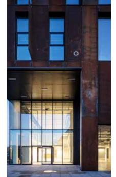
Il cubo è la caratteristica principale della nuova sede centrale della centrale elettrica di Helsingør. La struttura è adiacente alla centrale ed è caratterizzata da un'architettura vasta e distintiva. I pannelli rivestiti in COR-TEN® si integrano uniformemente e si abbinano ai colori naturali dei dintorni.
