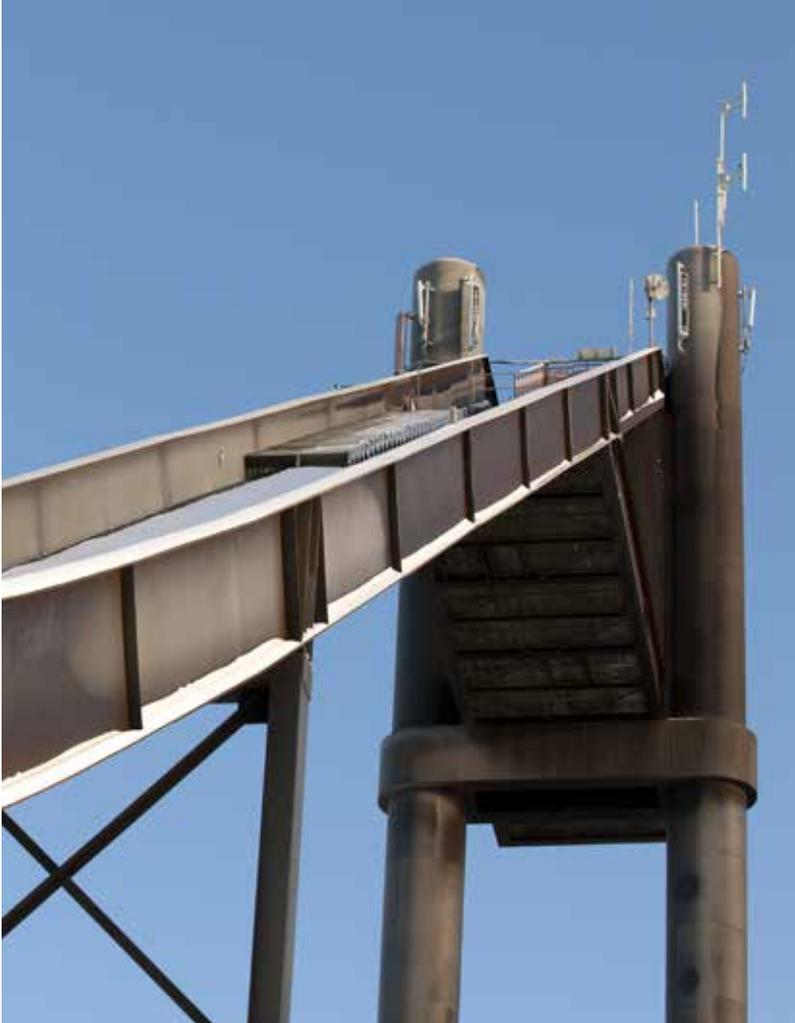
Die Patina verhindert ein weiteres Rosten des Stahls. Dadurch kann der Kunde über die gesamte Lebensdauer des Produkts Geld sparen. Für Stahlkonstruktionen, die aus herkömmlichen Stählen hergestellt werden, können die Kosten für Lackierung und Instandhaltung bis zu 15 bis 20 Prozent der Gesamtkosten ausmachen.
