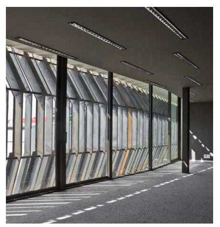
Die Vorderseite des Hauptgebäudes von Audenasa Headquarters ist aus vertikalen COR-TEN® Streifen gestaltet, die sich über die gesamte Länge des Gebäudes erstrecken. Jeder Streifen ist aus drei einzelnen COR-TEN® Blechen geschweißt, die an den Kanten um 90° gebogen sind.
