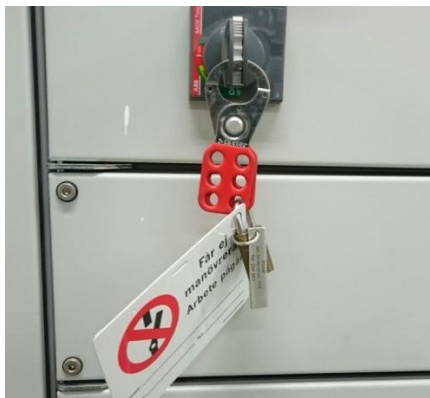
Säkerhetsbrytare med sax och personligt skyddslås (id.märkt)
