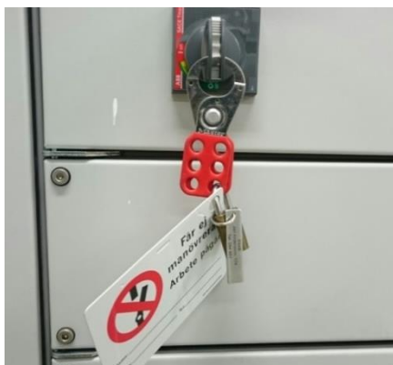
Säkerhetsbrytare med sax och personligt skyddslås (id-märkt)
