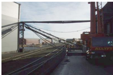
Nedkörning av ledningsstråk
