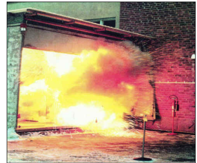
Ljusbåge i ställverk
