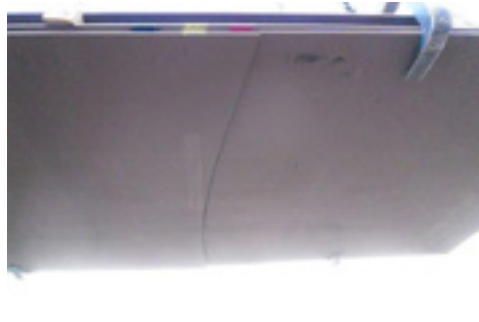
三点起吊结果出现裂缝的示例
