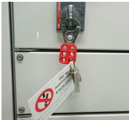
Säkerhetsbrytare med sax och personligt skyddslås (id.märkt)
