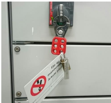
Säkerhetsbrytare med sax och personligt skyddslås (id.märkt)
