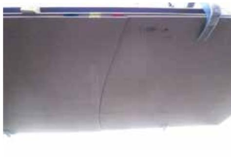
三点リフトにより亀裂が発生した例。
